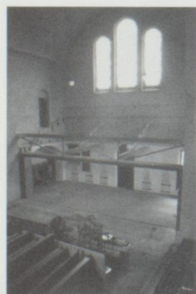
Abbruch der Westempore
